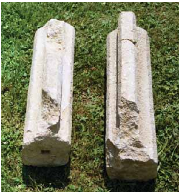
19/A. Gacsály, református templom. Trapézorrú boltozati bordák
