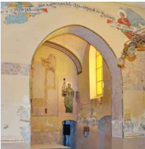
46. Zajta, római katolikus templom. A diadalív és a szentély keleti falában feltárt ablaknyílások
