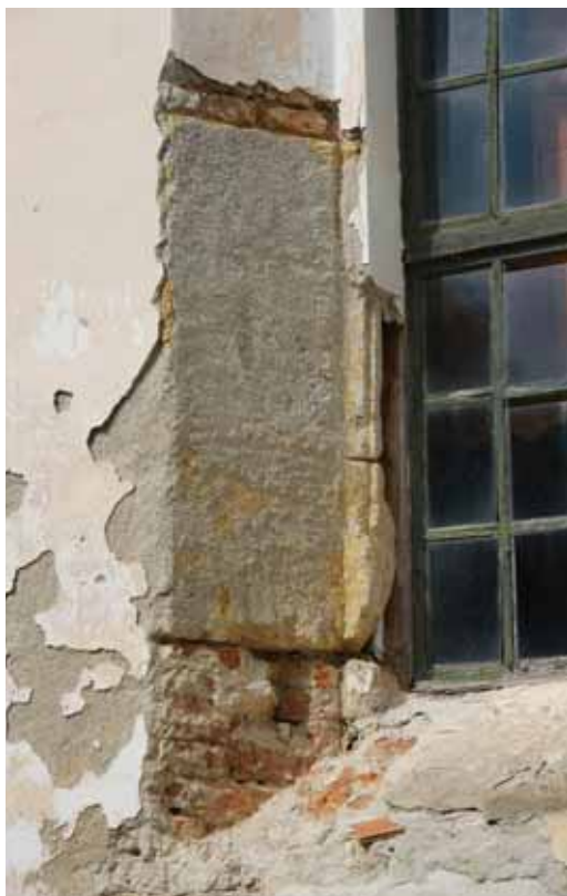
15. Gacsály, református templom. A hajó délnyugati ablakának gótikus kávája
