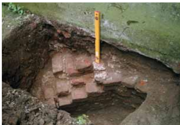
28. Gacsály, református templom. Átlós támpillér alapozása a hajó északnyugati sarkán
