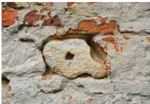
16. Gacsály, református templom. Falazóként felhasznált gótikus boltozati borda
