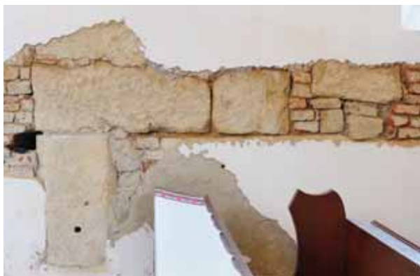
18. Gacsály, református templom. Falazókóként felhasznált kőfaragványok a déli hajófalban
