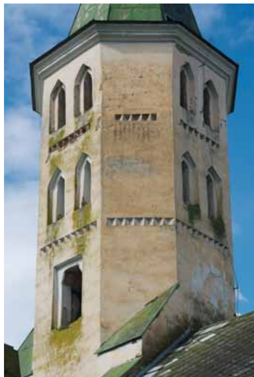
7. Gacsály, református templom. A hajó korábbi nyugati oromfalának csonkja a torony keleti oldalán
