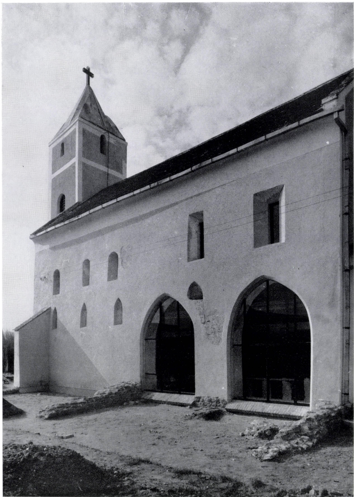
146. kép. A templom déli homlokzata a helyreállítás után
