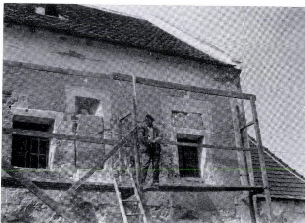
144. kép. A déli homlokzat keleti, felső részén előkerült ablakok
