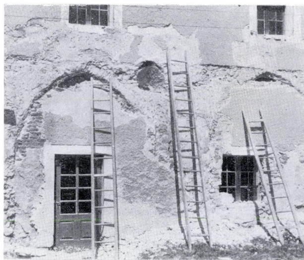
137. kép. A déli homlokzat keleti, alsó részén előkerült gótikus nyílások
