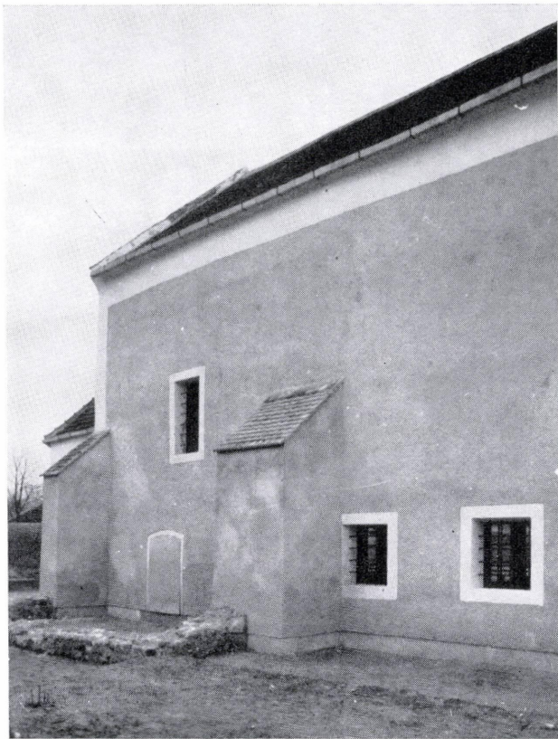
149. kép. Az északi homlokzat a torony felől
