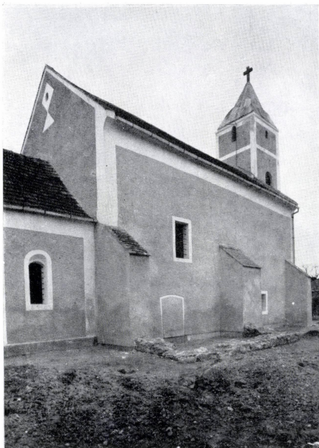
147. kép. Az északi homlokzat a munka befejezésekor
